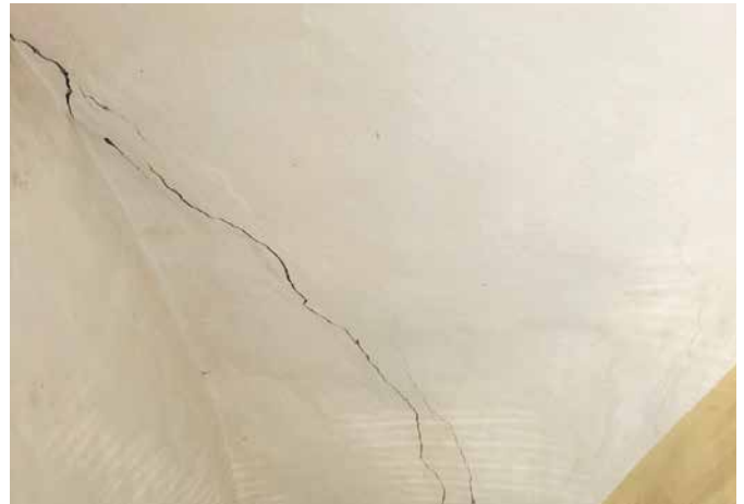
Risse im Gewölbe | Fissures dans la voûte
