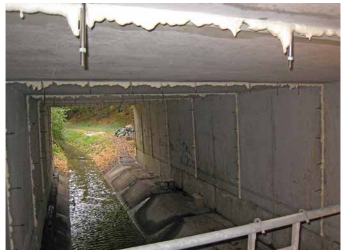
Herkömmliche Abdichtung ohne B-PROFILE® mit geringem Abdichtungserfolg Conventional sealing without B-PROFILE® with low sealing success
